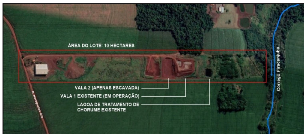
Figure 4. Imagem aérea da disposição final de resíduos de Paiçandu (PR) - Fonte: Google Maps (2020)
